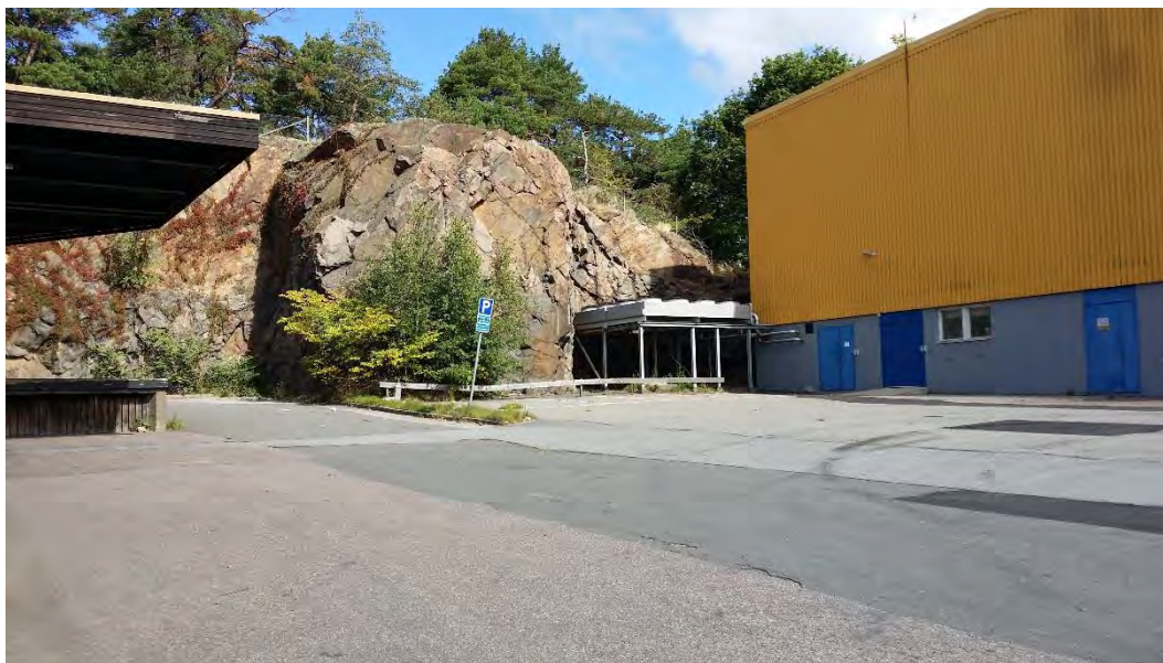
Figur 5 Vy nedanför ID 3 där ingen synlig bergförstärkning syns bakom befintliga byggnader
