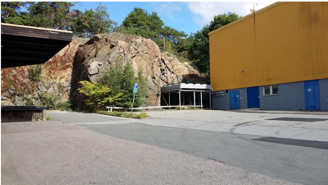
Figur 6.3. Vy nedanför ID 3 där ingen synlig bergförstärkning syns bakom befintliga byggnader.
