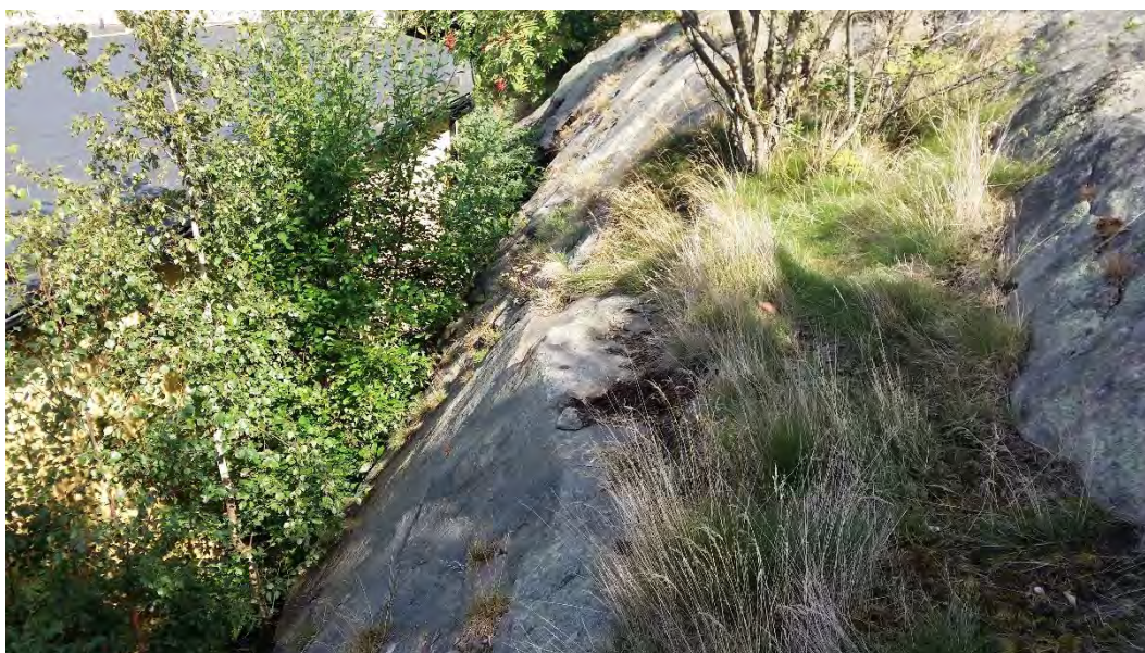
Figur 10 Vy från ID 5 som visar på glidytor ner mot befintlig byggnad och mycket vegetation
